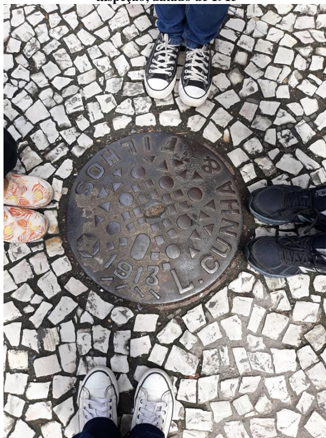
Figura 2 - Caminhada sobre urbanização e saneamento básico em Florianópolis, 31/03/2019: tampo de caixa de inspeção, datado de 1913
