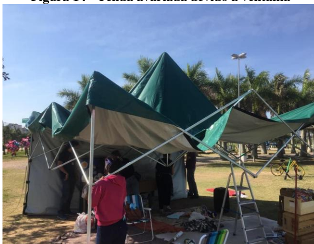
Figura 14 - Tenda avariada devido à ventania
