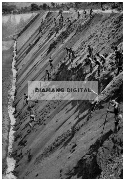
Trabalhos mineiros na mina de Luaco 6, através do desmonte hidráulico do cascalho - uma mistura de materiais estéreis e diamantíferos - para posterior remoção hidráulica do material estéril, 1956.
